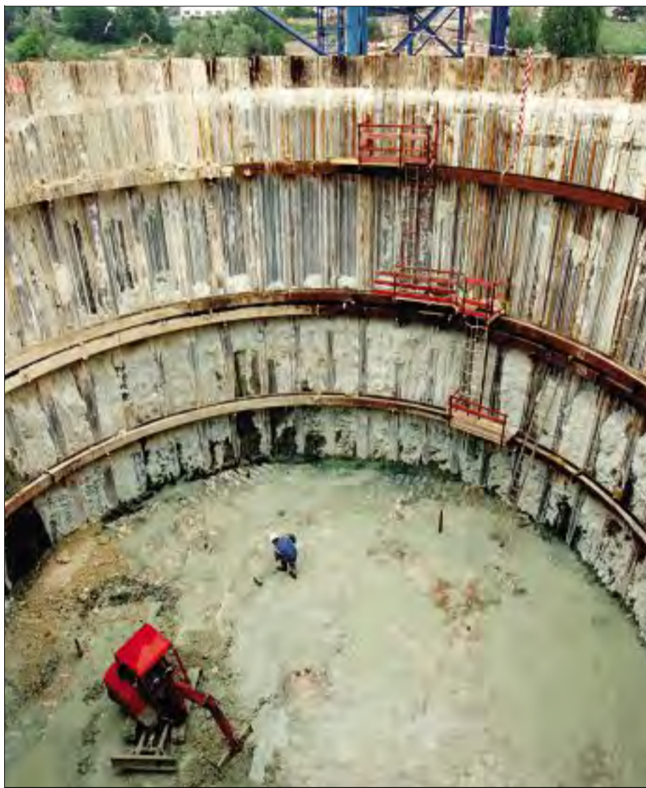
CALENDRIER. Les travaux de fondations du tripode sud, en mai 1999. 17.000 m 3 de béton ont été nécessaires selon l'entreprise Chantiers modernes, 4 fois plus que les 4.000 m 3 prévus.
