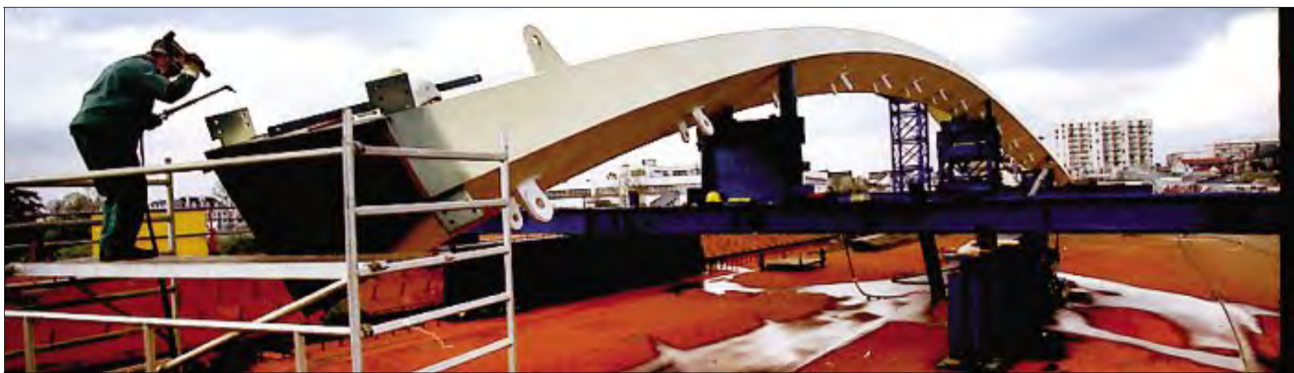
ARCHITECTURE. L'arc, culminant à 25 mètres de haut et s'étalant sur plusieurs dizaines de mètres, a dû être attaché à 28 paires de câbles en acier (suspentes), espacées de quatre mètres chacune.
